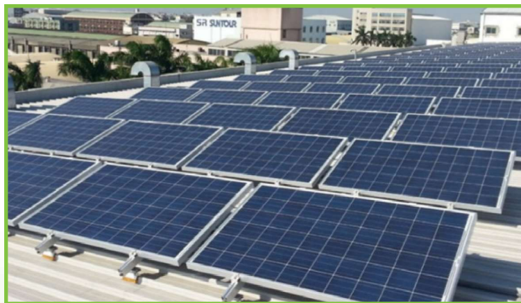
▲ 2015 年建置福興廠頂樓建置太陽能板
